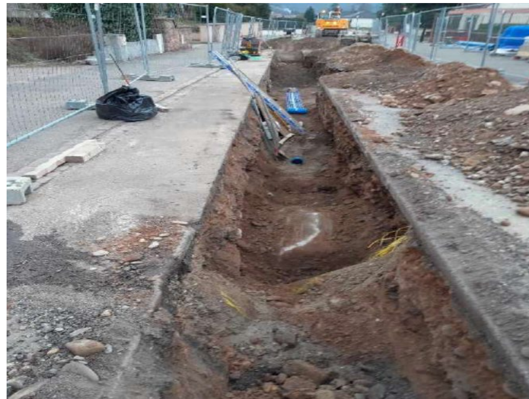
Pose de la conduite d'eau potable en FONTE DN 100 mm
