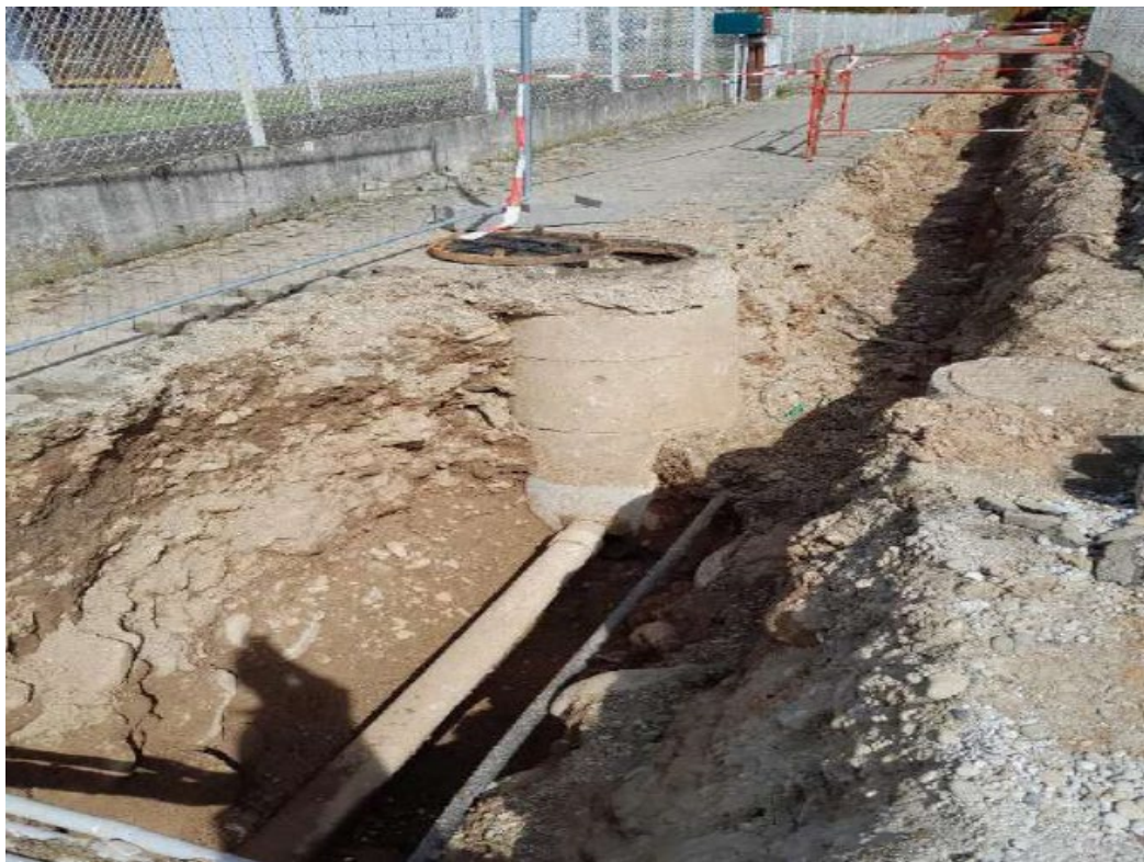
Rénovation d'un branchement d'eau potable
