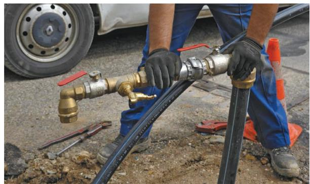
Suite à des constats de fuite sur le réseau d'eau potable, **un renouvellement du réseau rue de la Flieh à Kaysersberg** est en cours, les travaux dureront jusqu'à mi-mai. Durant cette période, le réseau d'eau potable sera remis à neuf et des travaux de mise aux normes des compteurs seront réalisés pour les installer en limite de propriété.
