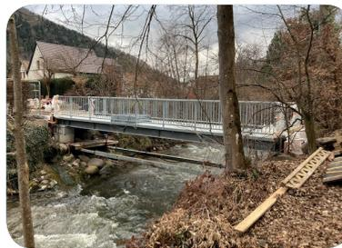
Suite au démontage de l'ancienne passerelle près du camping de Kaisersberg en raison de faiblesses de la structure porteuse, une **nouvelle structure** métallique a été posée fin janvier. Les
