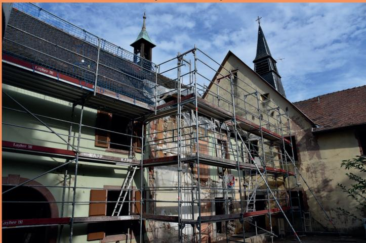
Les travaux du musée Albert Schweitzer sont en cours : le chantier avance bien au niveau du sous-sol avec le montage du mur porteur et de la cage d'ascenseur. Au premier étage, après la nouvelle ossature en bois, le premier sol en bois a été posé en attendant le parquet. L'échafaudage est en place pour les travaux extérieurs depuis septembre.
