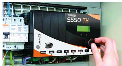
Le chantier de la sécurisation des réseaux de Sigolsheim s'achève avec la mise en route de l'automatisation des réservoirs du Mambourg. Le remplissage des réservoirs est maintenant piloté à distance par le SDEA et surveillé 24h/24.
